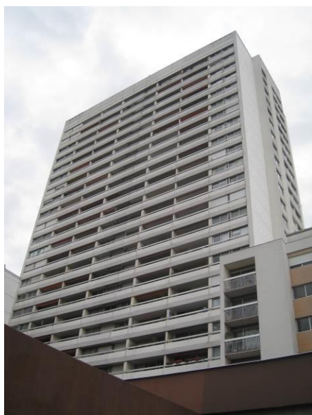
Façade Ouest sur cour
