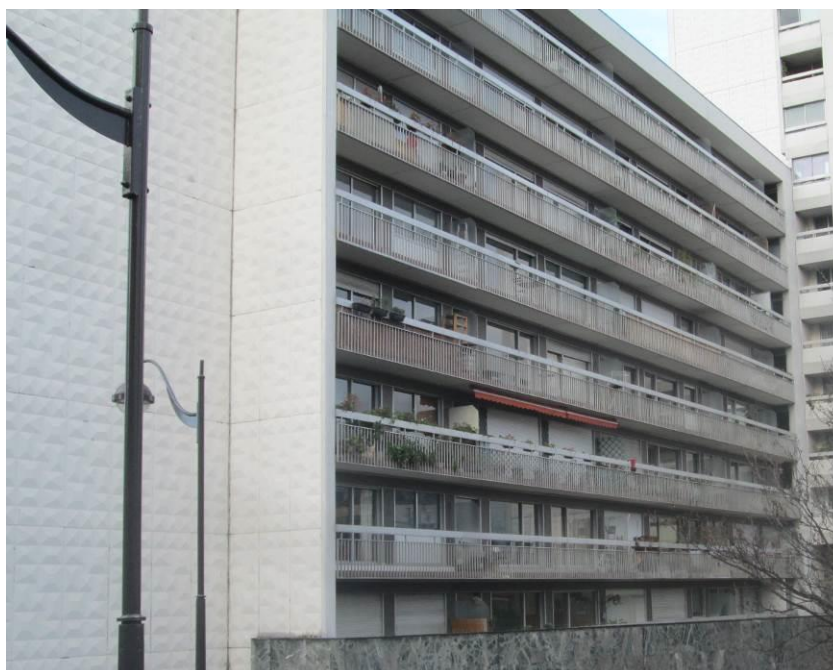
Façade Est rue Danjon
