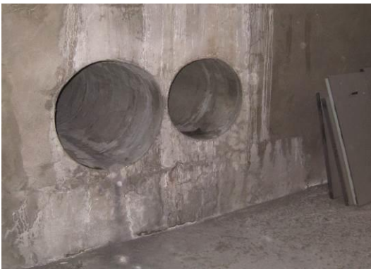
Gaines d'extraction pénétrant dans Le local extracteur
