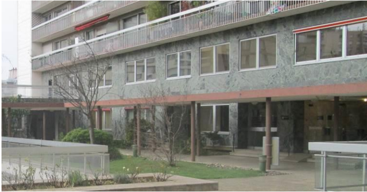
Façade Sud sur la cour
