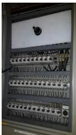
L'énergie électrique est distribuée par plusieurs armoires électriques. Elles sont soit implantées dans des placards techniques prévus à cet effet, soit installées en applique sur des parois.
