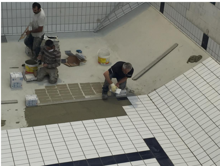
Pose du carrelage en double encollage à l'aide d'une colle spécifique au SEL.
