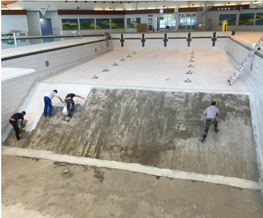
Application S.E.L Système d'Étanchéité Liquide TRILATEX de KEMPER SYSTEM Résine d'étanchéité sous carrelage
