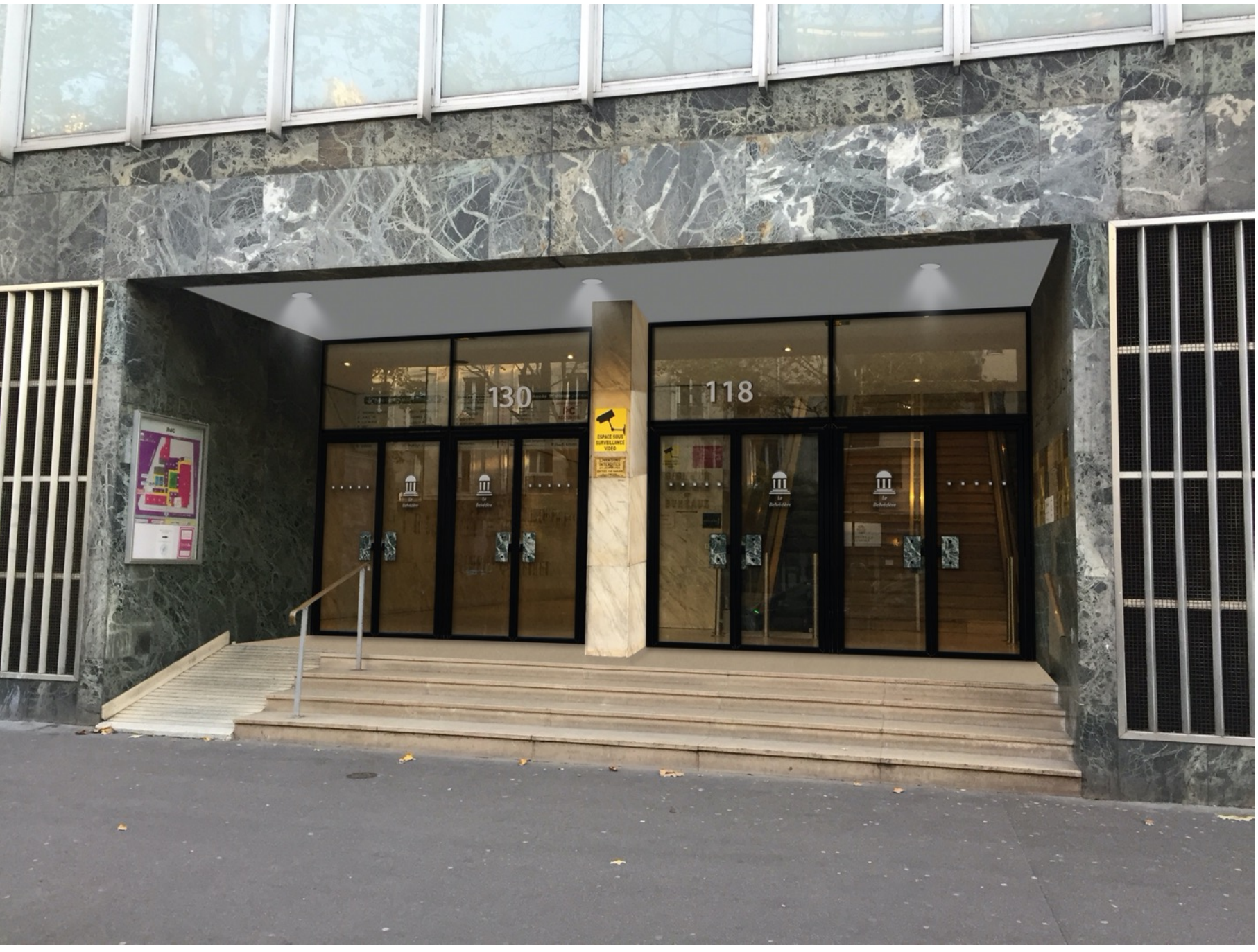
Image 2 : Façade vitrée projetée avec huisseries en acier thermolaqué noir
