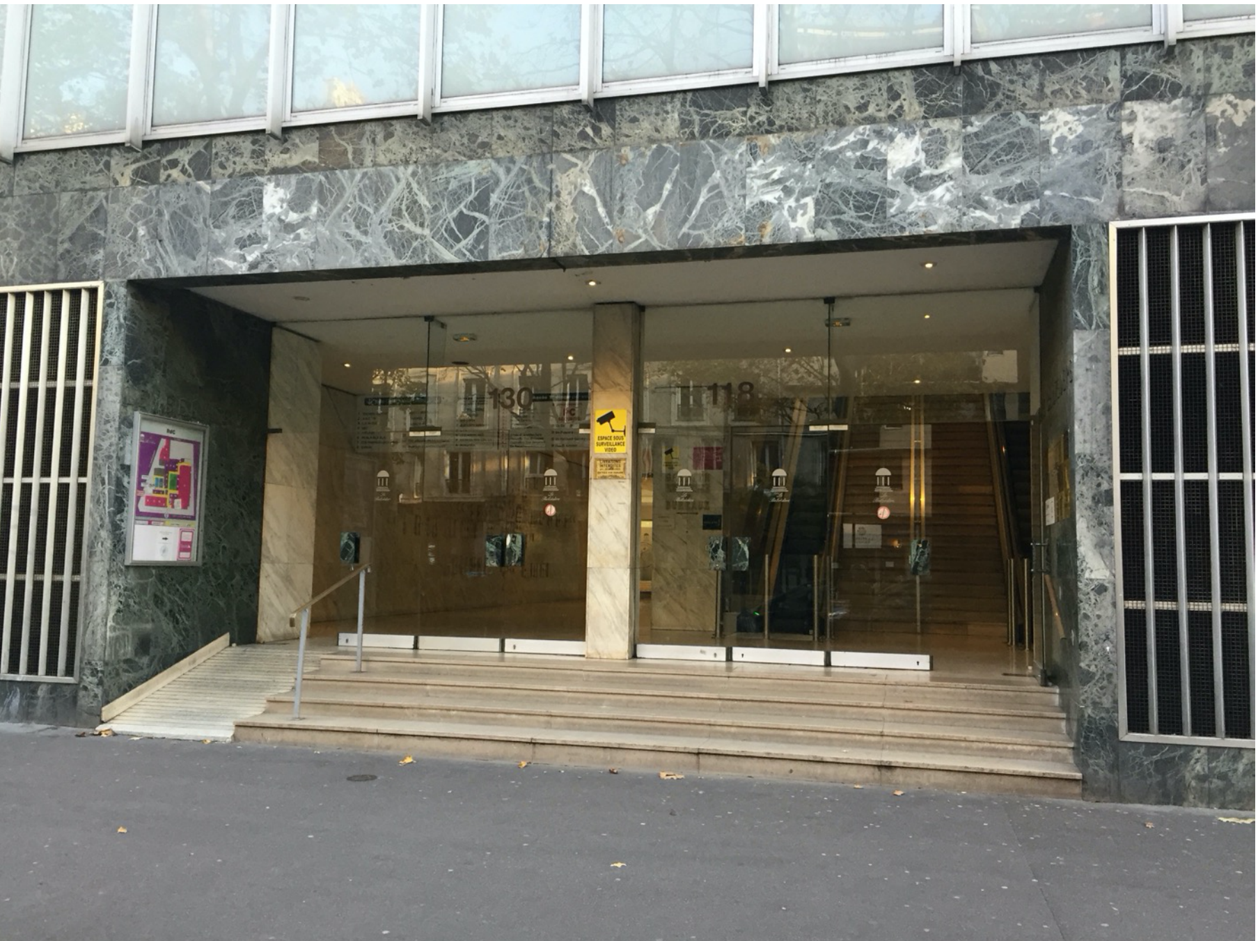
Image 1 : Façade vitrée existante
